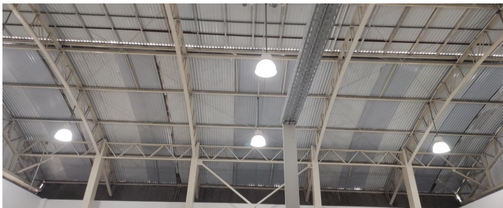
Imagem 26: telhado no detalhe
