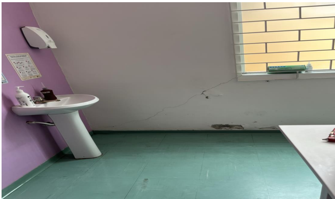
Imagem 33: no detalhe rachadura na parede e infiltração
