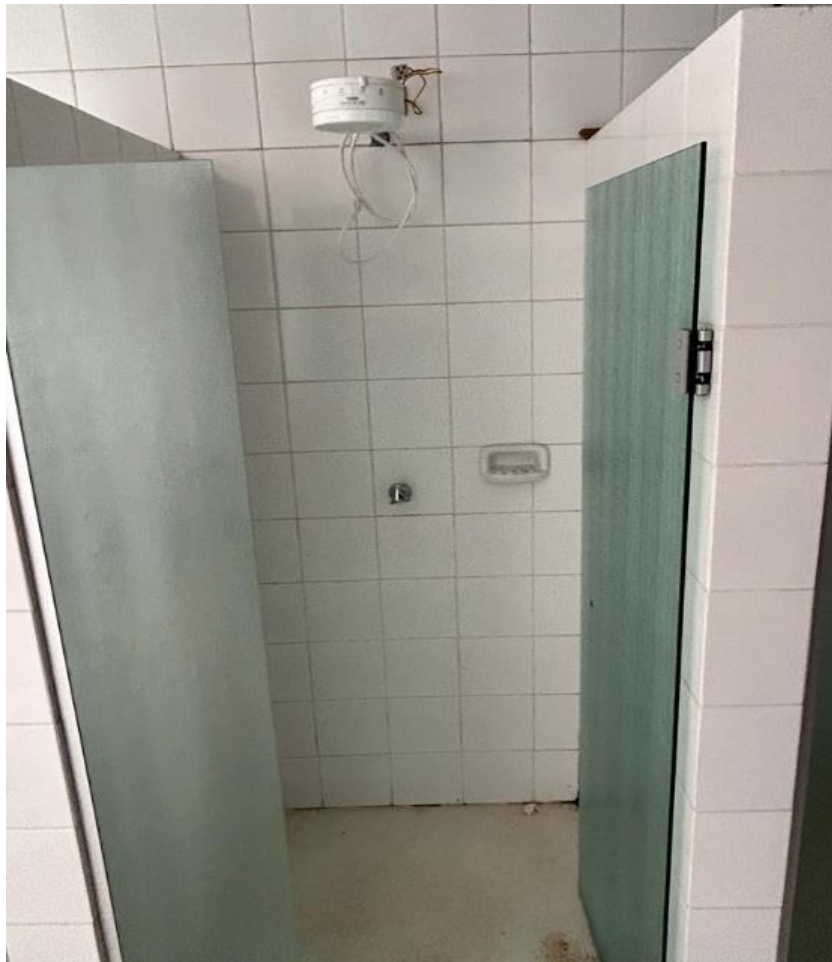
Imagem 14: Chuveiro do Vestiário Masculino
